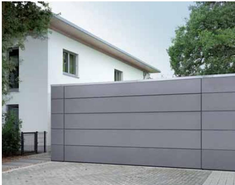
La base para el revestimiento de fachada consiste en una puerta seccional industrial ALR 40, una estructura de aluminio con revestimiento de paneles. Las puertas industriales son especialmente estables y han sido concebidas para un funcionamiento permanente fiable.
